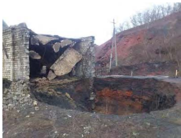
Рис. 1. Провалля, яке утворилось біля устя свердловини аварійної шахти № 29, пов'язаної виробками із шахтою «Лісова» Донецької області (припинила видобуток в 2002 р.)
