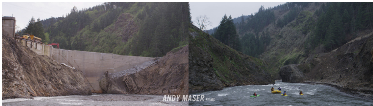
Рис. 5. Демонтаж ГЕС у США
