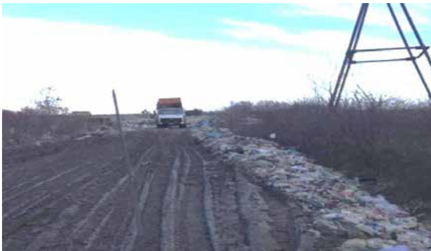
Рис. 1. Засипані узбіччя дороги, яка веде до Броницького сміттєзвалища
