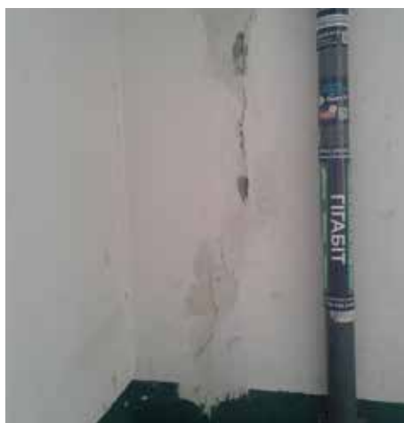
Рис. 5. Стан залізобетонної стіни у будинку на Оболоні після землетрусу 1977 р. Фото 2020 р.
