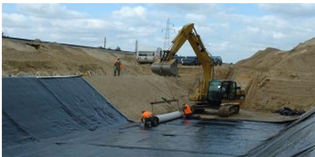
Рис. 1. Сучасні методи запобігання надходженню стоків із накопичувачів промислових стічних вод
