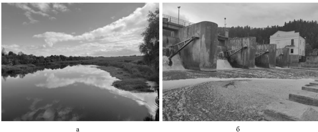
Рис. 8. Специфічні екосистеми у районах малих гідроелектростанцій: а) евтрофікація у верхньому б'єфі Сокальської МГЕС; б) скупчення сміття у нижньому б'єфі Явірської МГЕС (фото М. Лопушанської)
