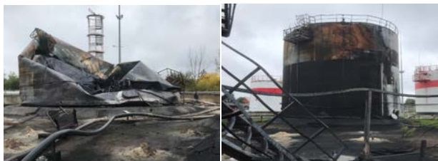
Рис. 1. Приклад руйнувань ємностей з нафтопродуктами нафтобази «Амік» у м. Бородянка [3]
