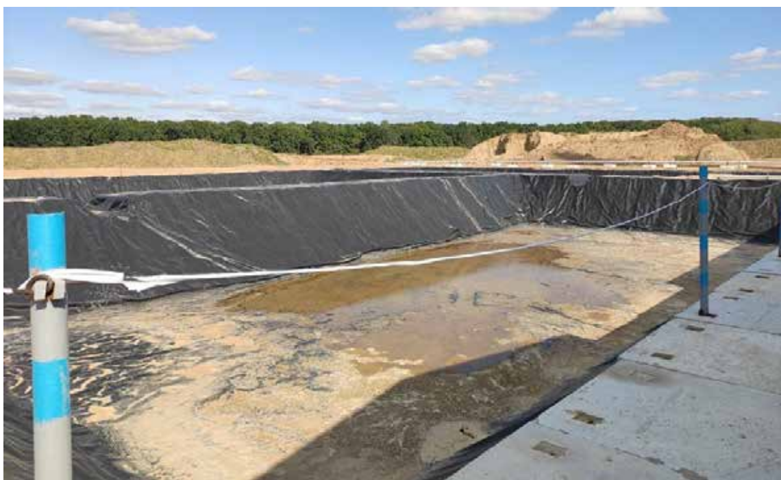
Рис. 2. Протифільтраційний екран з геомембрани
