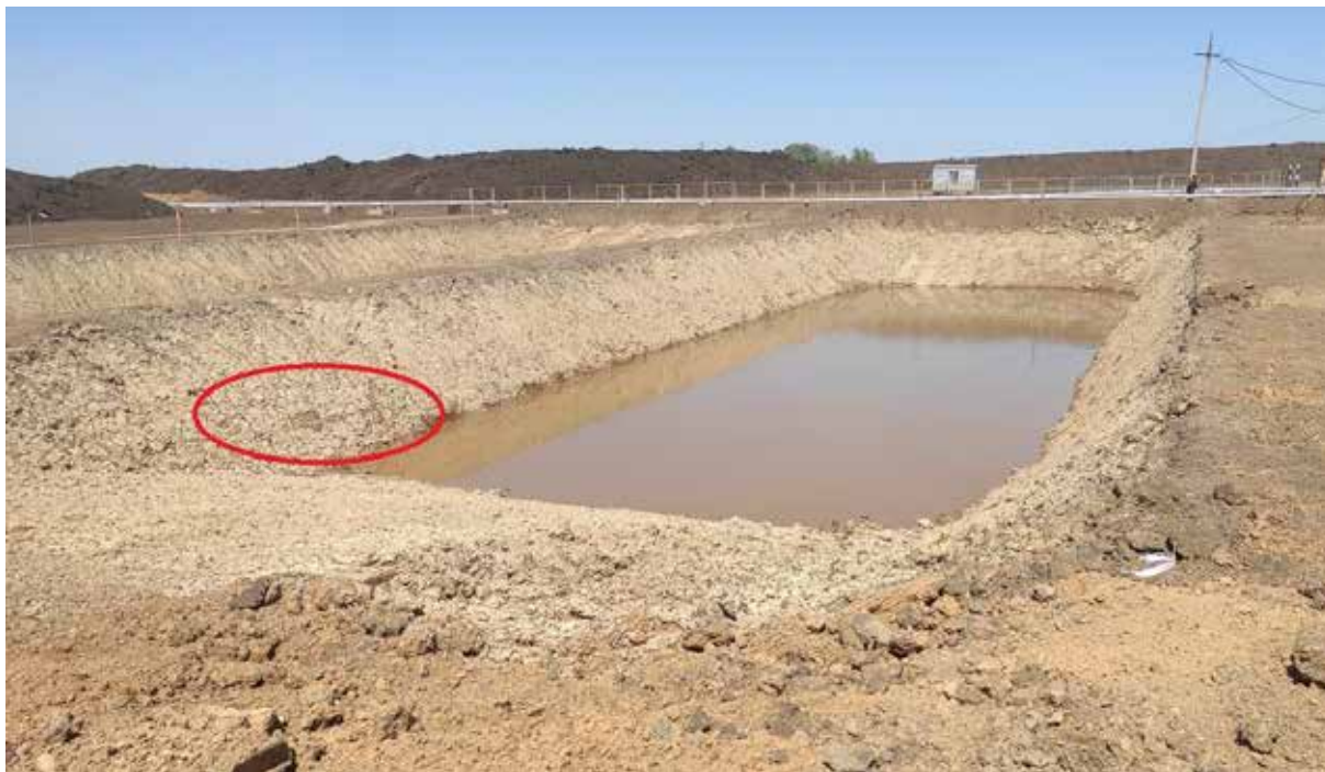
Рис. 1. Екран з гідролізованого поліакриламіду та бентонітової глини
