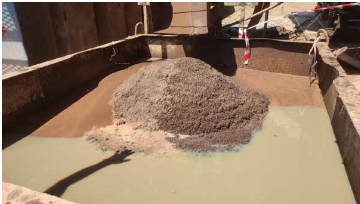
Рис. 3. Відходи буріння з використанням бурового розчину на дизельному паливі
