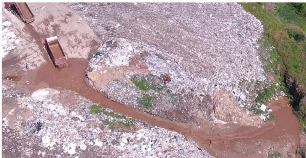
Рис. 4. Розміщення відходів буріння на полігоні (ПВ) побутових відходів у Харківській області [13]
